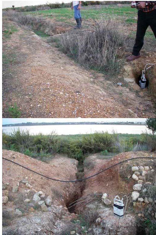
Sector supuestamente restaurado: tierra que cubre los fosfoyesos erosionada por la lluvia (nivel de radiación gamma de 2 a 9 veces superior a lo normal)
